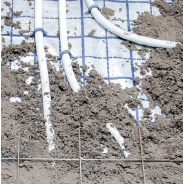
Konventioneller erdfeuchter Zementestrich mit Bewehrung .
